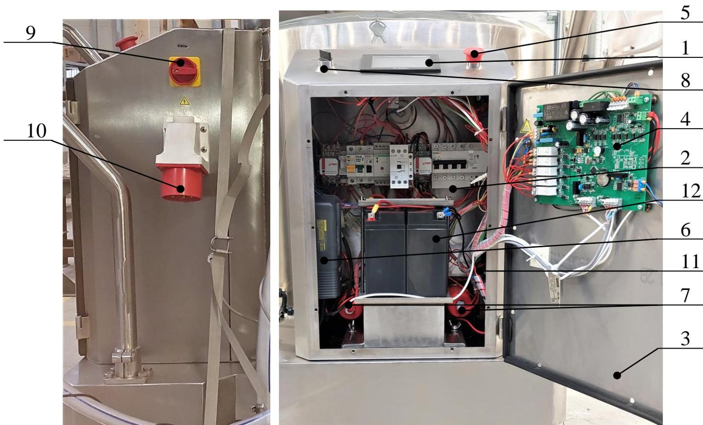
1 – Панель управления пастеризатором; 2 – силовые элементы; 3 – крышка электрошкафа; 4 – плата управления; 5 – аварийный выключатель; 6 – Зарядное устройство 24В; 7 – блок-ТЭНы 1.5'' по 4.5кВт; 8 – переключатель пистолета-дозатора; 9 – выключатель пастеризатора; 10 – силовая розетка; 11 – блок управления электроприводом; 12 – аккумуляторы; 13- подставка аккумуляторов
